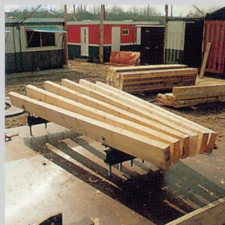
◀ Fertiges Trichterelement ohne Schalhaut
