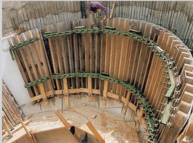
WEHA®-Trichterschalung beim Faulturm. Die Elemente werden gegen den Betonauftrieb gesichert
