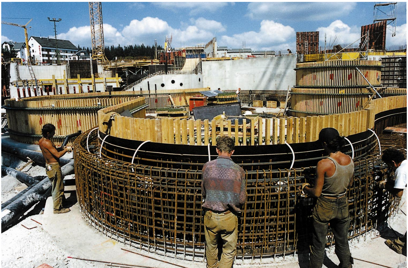
Die WEHA®-Gliedergurtschalung beim Bau der Rennsteigtherme Oberhof
