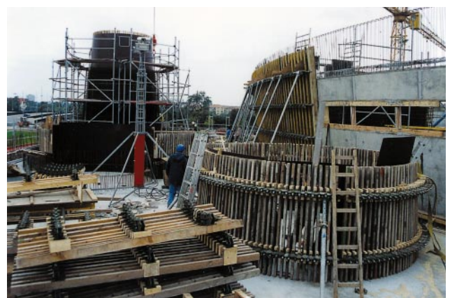
Im Hintergrund: Innenschalung beim Rutschenturm und konische WEHA®-Trägerschalung. Im Vordergrund: WEHA®-Gliedergurtelement.
