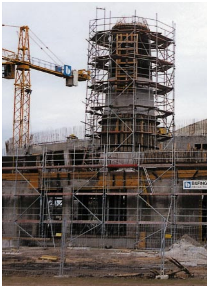
Konische WEHA®-Gliedergurtschalung für den Rutschenturm des Freizeitbades Magdeburg.
