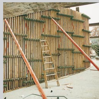
WEHA®-Gliedergurt-schalung bei Garagen-einfahrt mit Gefälle
