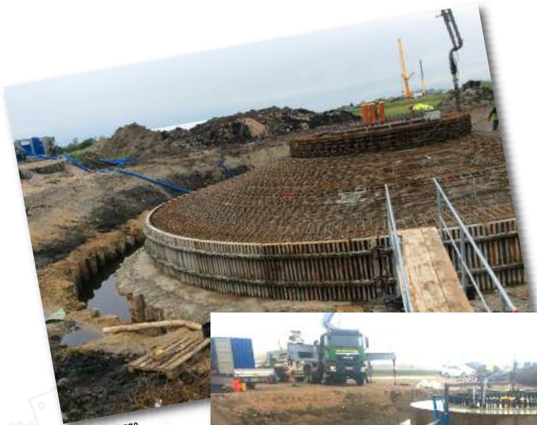
Vor der Betonage
